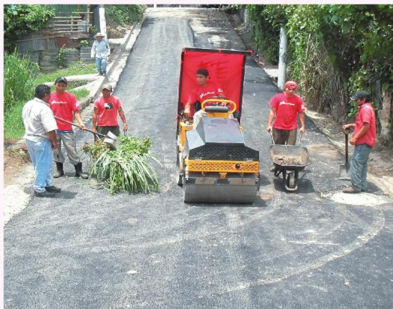
Trabajadores municipales reparan calles rurales de Ciudad Delgado
